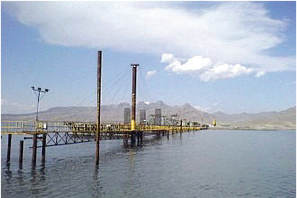
Şəkil: 4. Urmiya gölü üzərində inşa edilən körpü (2005)
